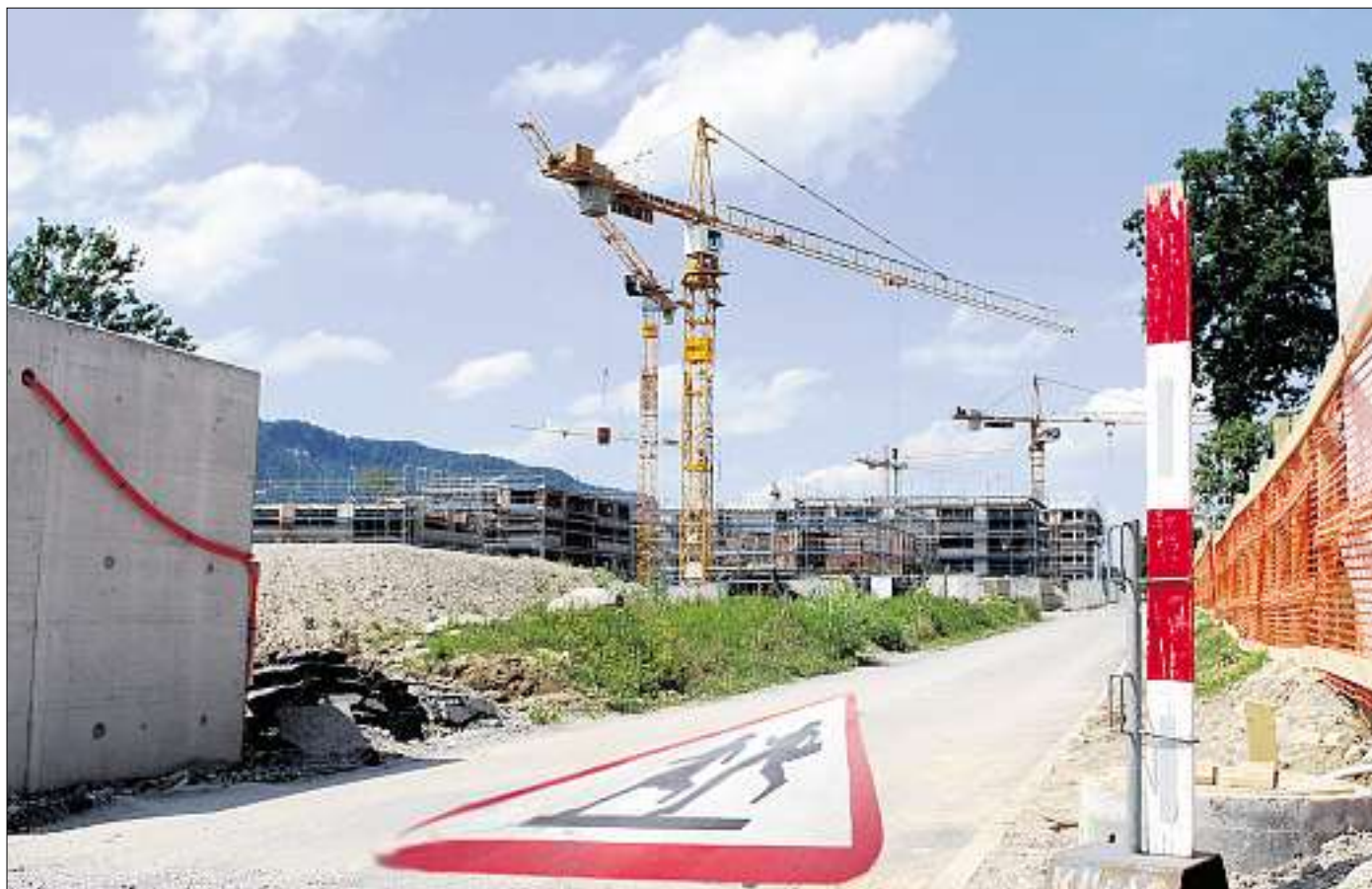
In Adliswil wird eifrig gebaut – das zieht Neuzuzüger und damit auch Kinder an. Wie die Schule diesen Ansturm bewältigt, ist unklar. (tjb)
